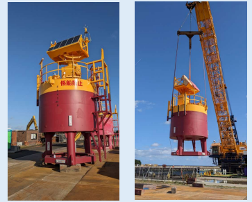
【南側係留式ブイ工事風景】
